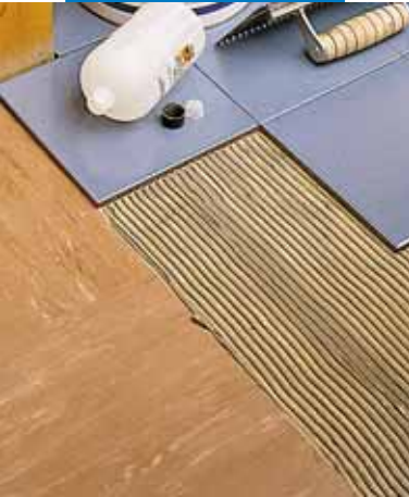
Verlegung von Fliesen auf bestehendem PVC-Belag
