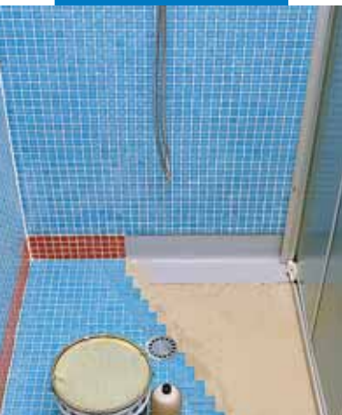
Abdichtung und Verlegung von Glasmosaik mit Keralastic
